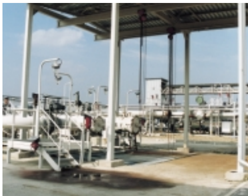
Vstupní a výstupní stanice ropy a ježkovací komora Litvínov a MERO IKL.
