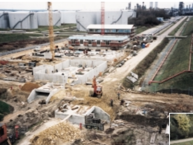
Pohled na staveniště provozní budovy a čerpací stanice.
