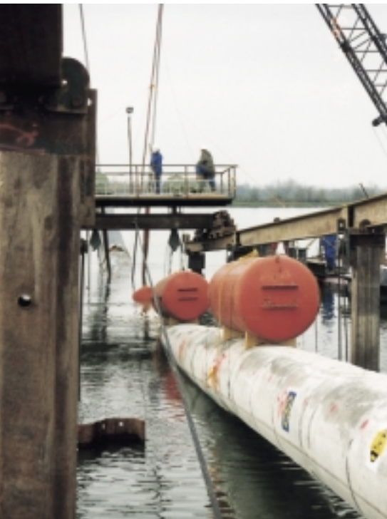
Budování shybky přes Dunaj, tzv. Donau - Düker. 11.- 13. duben 1995.
