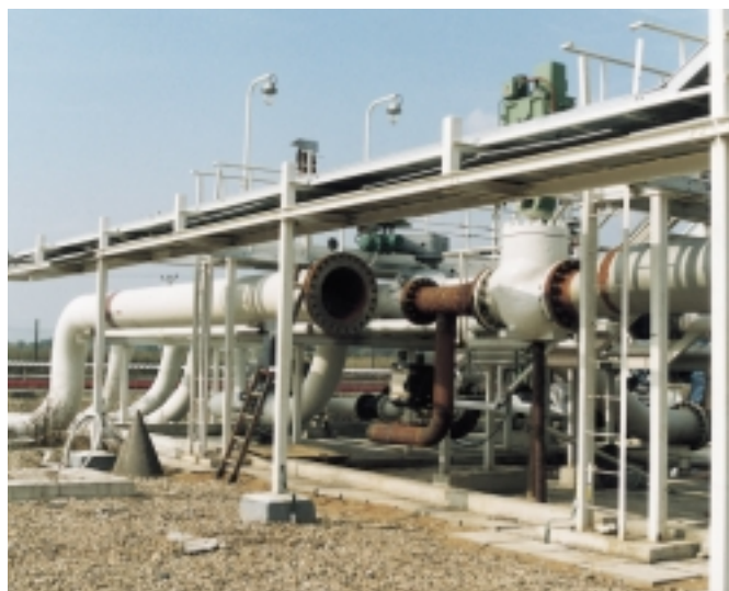
Měřicí a regulační stanice, regulační ventil Družba.
