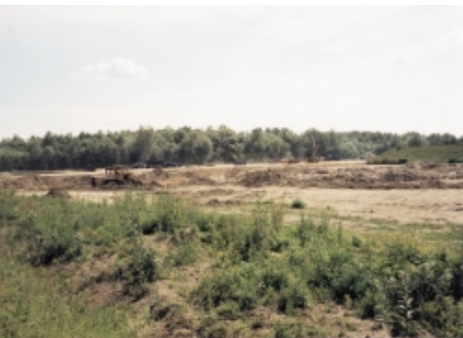
Úpravy pozemku pro stavbu tankoviště MERO ve Vohburgu. Pohled ze severozápadu.
