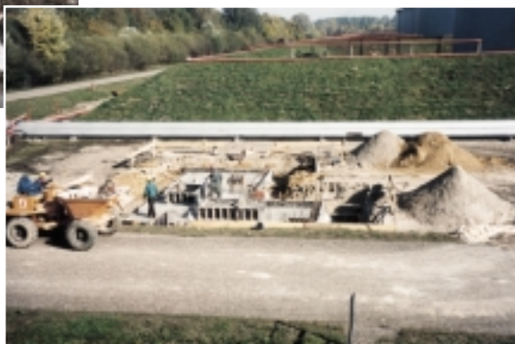
Výstavba vstupního manifoldu.
