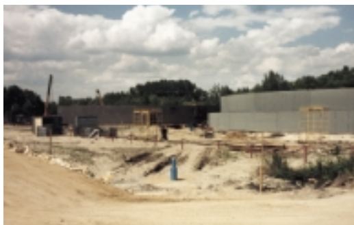
Výstavba nádrží 3 a 4. Léto 1994. Pohled od jihozápadu.
